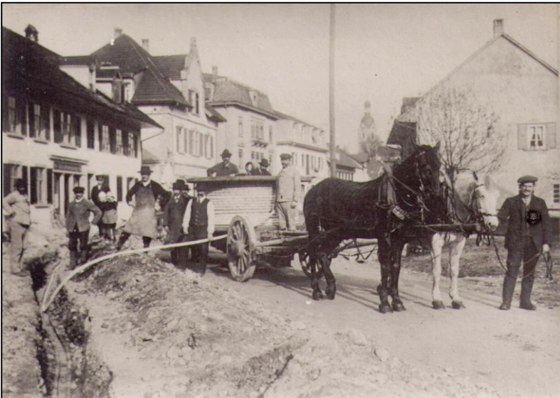
Verlegung der Kabel im Schönenwerder Ausserdorf für die neu gegründete EGS, um 1896
