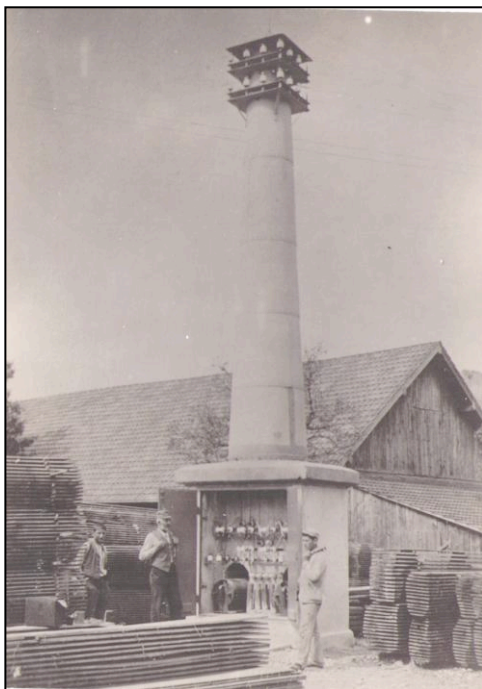
Verteilerstation II der EGS in Niedergösgen, Kistenfabrik Erb, von 1896 bis 1911 in Betrieb
