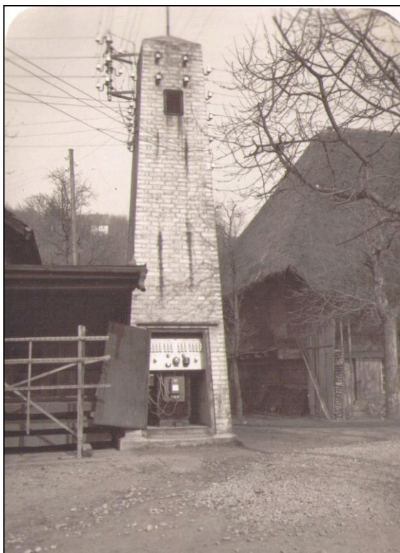
Verteilerstation VII der EGS in Nieder- gösgen, Filzfabrik
