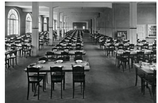
Kosthaus: grosser Saal im Originalzustand.
