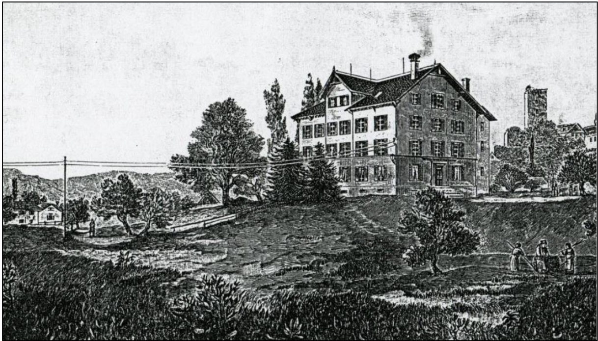
Fabrik Niedergösgen mit der ersten Leitung, die elektrischen Strom von der Anlage in Schönenwerd in die rund 400 Meter entfernten Fabrikationsräume führte. Stahlstich von 1890.
